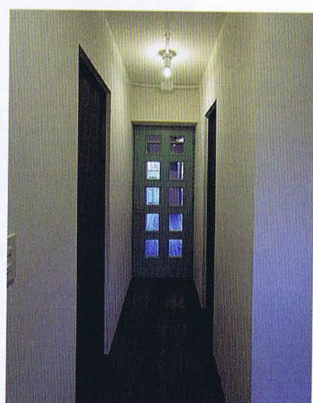
LDKと玄関をつなぐ廊下。天井の照明は躯体に直接固定し、露出配線とすることで天井高さを確保
