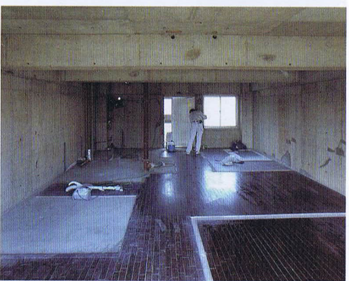
解体後の様子。既存の床はそのままにして上から張り替えている
