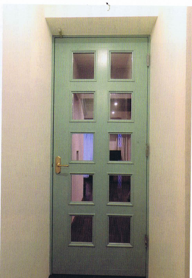
廊下とLDKを仕切る建具は既存の再利用。高さが変わったため、下框に木材を足して延ばし、再塗装している。ドアノブは施工支給品
