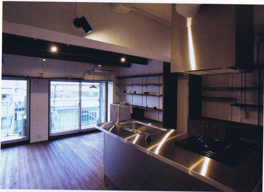
竣工時の様子。天井は石膏ボードを張らず、躯体を白く塗装して仕上げ、天井高さを確保
