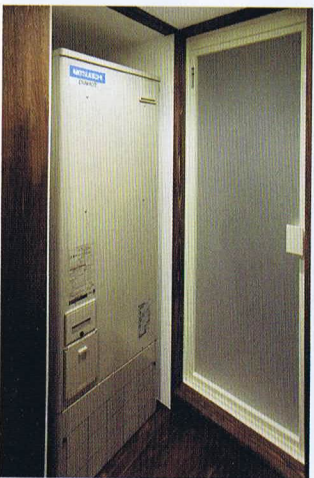
電気温水器を廊下側のスペースに移設することで、水廻りのレイアウトがすっきりした。洗面脱衣所の扉が電気温水器の扉を兼ねる無駄のない設計
