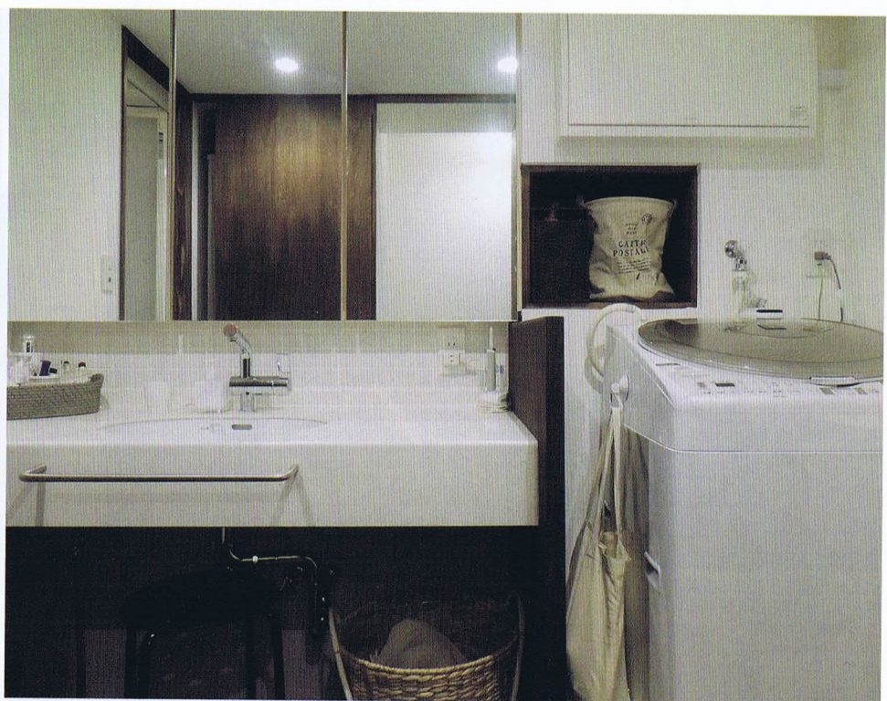
電気温水器の配置を変えたことで、洗面と浴室の向きを変えることができ、効率的にスペースが使えるようになった。ミラーの背面は収納。配管が干渉しない壁面にニッチを設けるなどスペースを最大限に活用している
