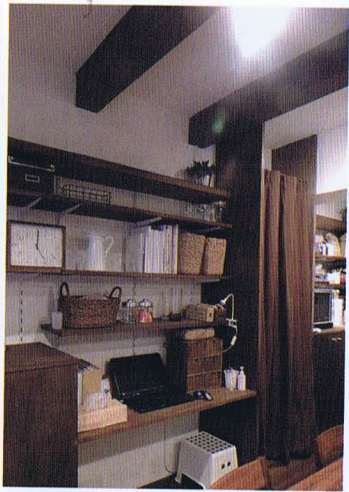
ダイニングとキッチンの壁面はガチャ柱を用いた可動棚が設けられている。カーテンで覆われている部分は掃除機などを入れるスペース。カーテンは施主のDIY
